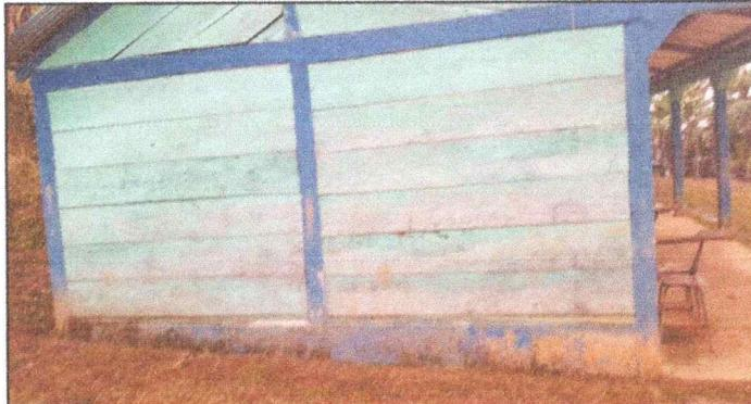
Foto 1: Muro de madera del modulo
